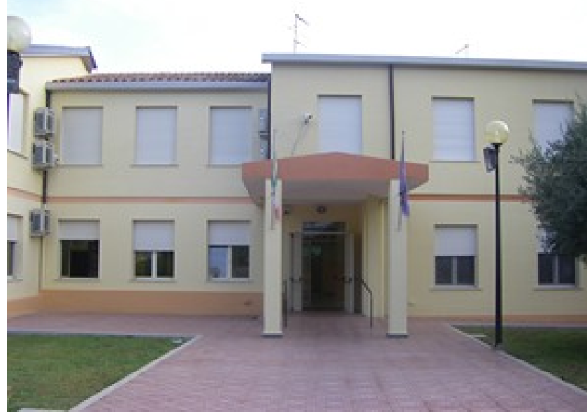
Il nuovo edificio della scuola di viale della libertà, una sala per i professori, una sala
