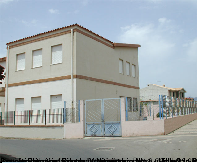
Il nuovo edificio della scuola di viale della libertà, una sala per i professori, una sala
